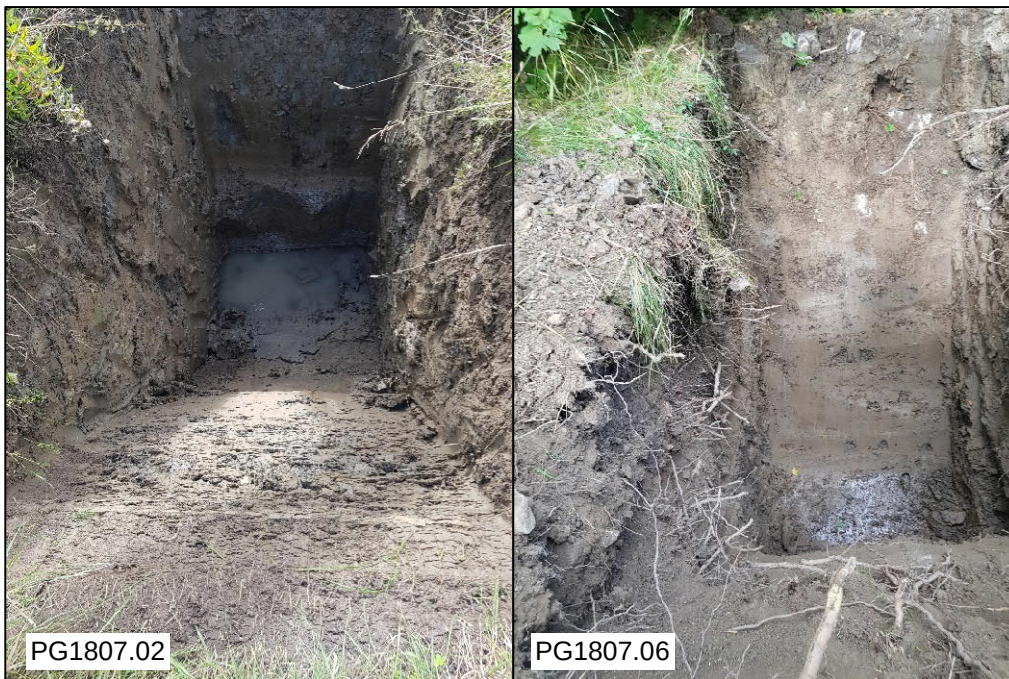
Figur 4 Två djupare provgropar från område 1807, brandövningsplatsen.
