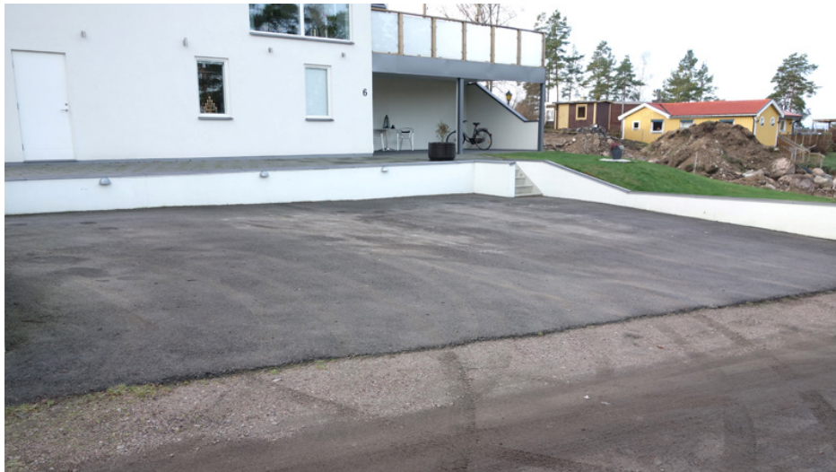
Asfalterad stor yta som lutar ut mot gatan. Exemplet är från Marby.
