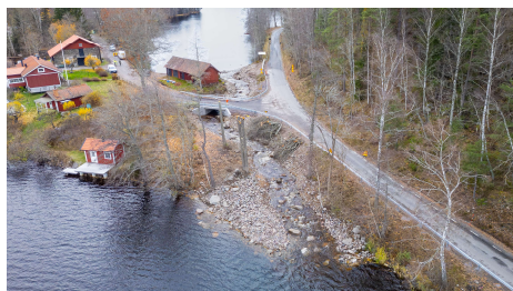
Återställt ursprungligt sjöutlopp från Vekmangeln till Näknen, Pjältåsystemet.
