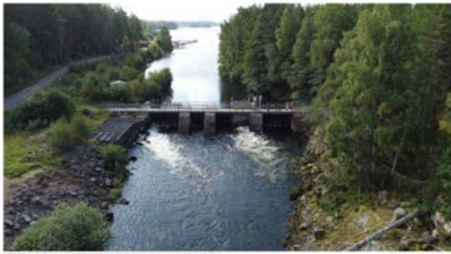
Väl Laxberg i Storvatten kommun ska en ny fiskväg för älvar och sjöar byggas. FOTO: JONAS PERSSON
