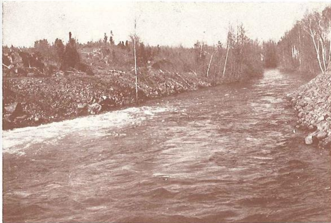
I samband med anläggandet av dambyggnaden vid Laxberg utfördes ett kanaliseringsarbete av Svartån norr om dammen.
