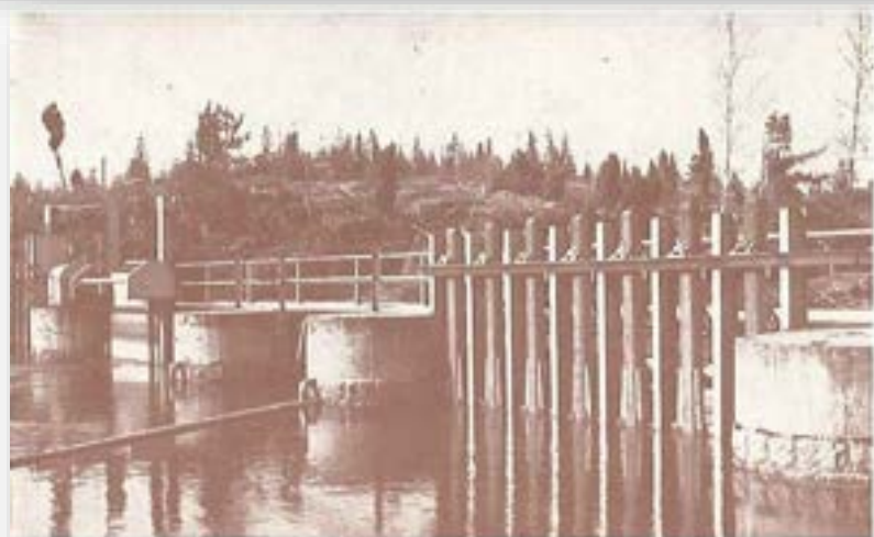
Dambyggnaden vid Laxberg har flera luckor som sköts manuellt samt en stor och bred lucka som sköts från ställverket i Bockholm.
