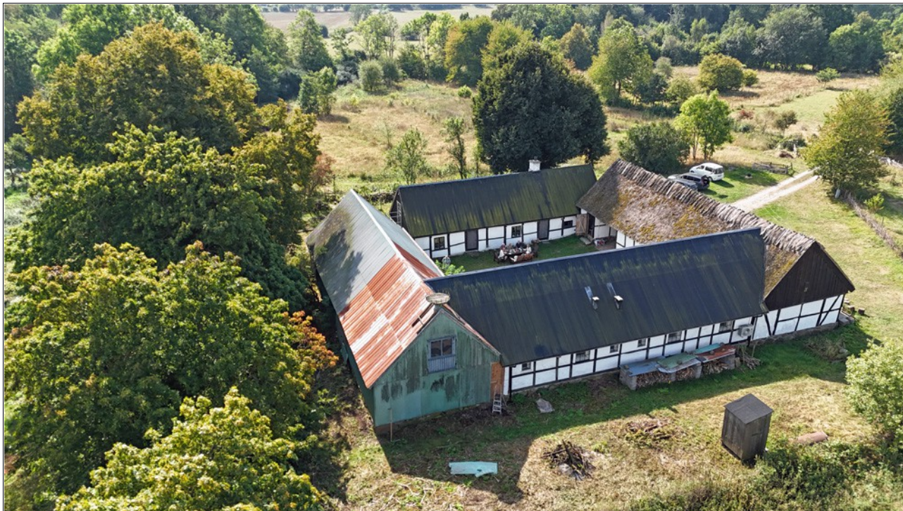
Hörjelgården sedd från norr. Det är den vänstra, implåtade längan, ladan, som vi vill renovera.
